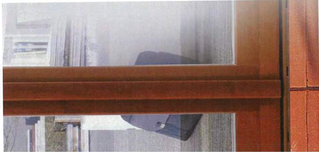
La soglia a taglio termico evita ogni possibile condensa. A threshold with thermal break prevents any condensation.
